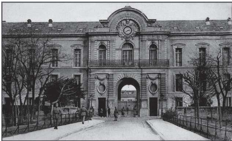
Caserne du Génie à Montpellier
